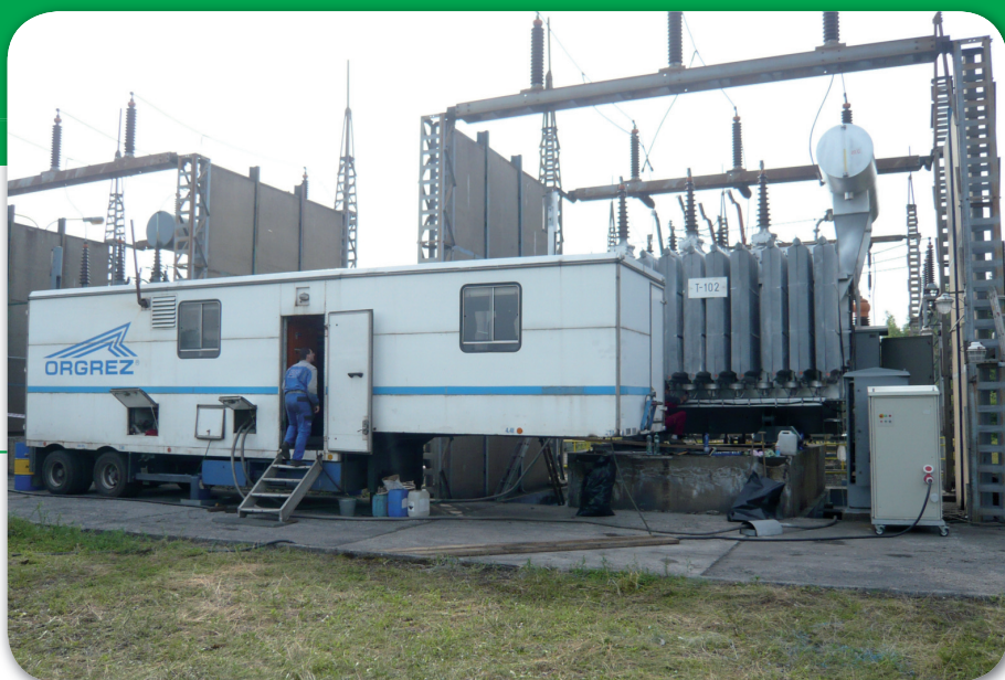
Vysoušení transformátoru metodou NF+regenerační zařízení.
